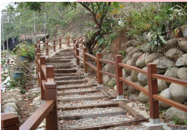
大坑登山步道新工法：碎石注油木枕步道
